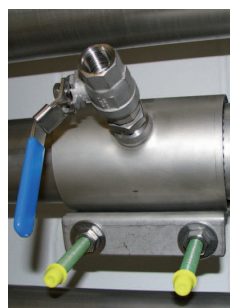
B Collar de perforación
