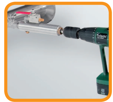
Perforación bajo presión
